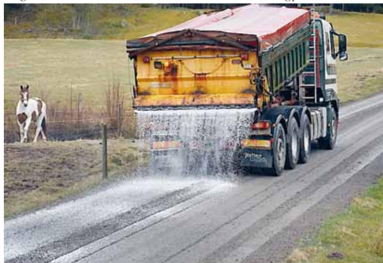
Den nyhyvlade och bevattnade vägen saltas med kalciumklorid, som effektivt binder dammet till vägbanan.
