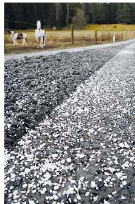
Nyspriden flinga av kalciumklorid. Snart tas den upp av vägbanan, binder dammet och ger en hållbar och säker väg.
