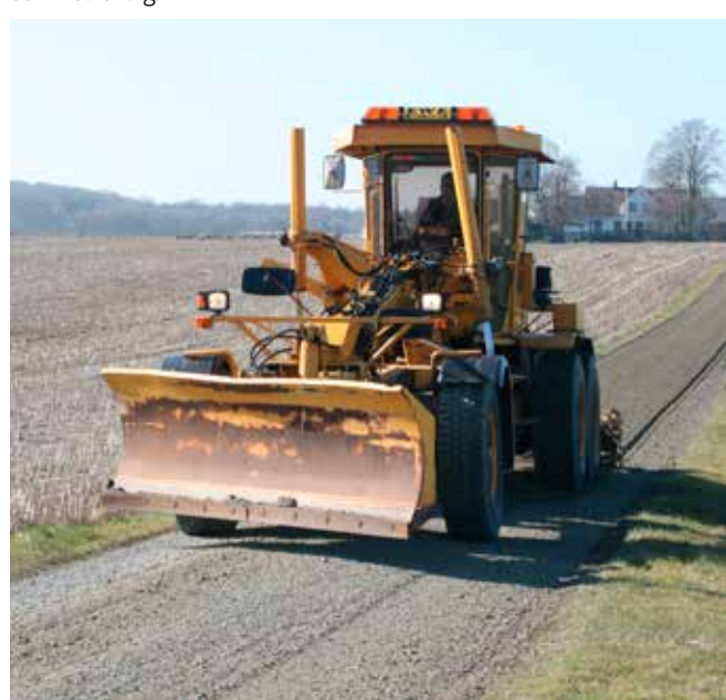
Vägen hyvtas och ytan ruggas upp ordentligt innan det är dags att sprida ut vägsaltet.
